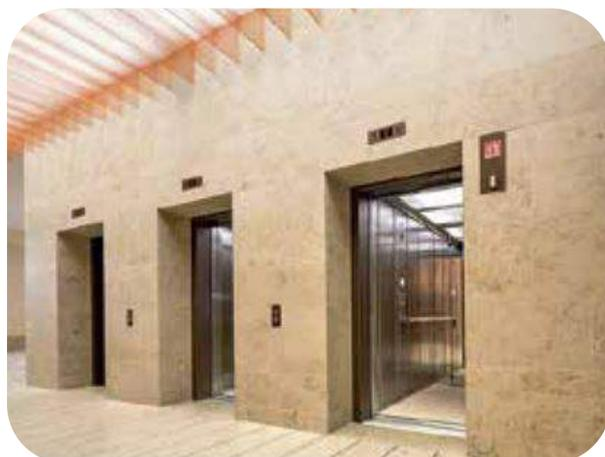
**Feuerwehraufzüge** sind gemäss Aufzugnorm EN 81.72 konstruiert, um im Notfall von der Feuerwehr benutzt werden zu können. Somit ist im Brandfall der Zutritt für die Feuerwehr gewährleistet.
