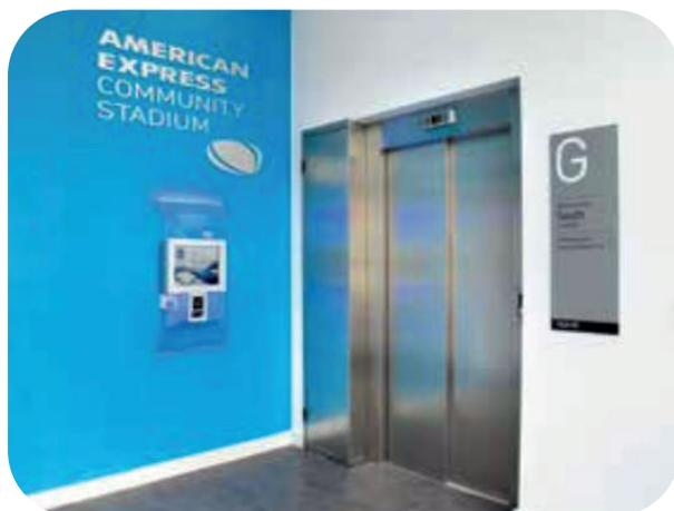
**Gegen Vandalismus geschützte Aufzüge** sind gemäss Aufzugnorm EN 81.71 konstruiert. Es werden spezielle Werkstoffe verwendet, die diesen Aufzug zur extra robusten Lösung für Kranken- und Pflegehäuser machen.
